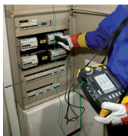
Maintenance tertiaire & industrielle, diagnostics & contrôles
